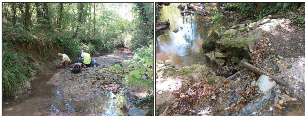
Figure 109 – Vue de l'intérieur de l'ancien bassin de décantation de La Curie installé dans le lit du ruisseau de Planioles (berge constituée de résidus) et vue des vestiges de l'ancien barrage qui retenait le bassin (2018)
