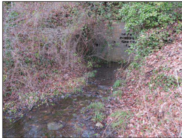
Figure 18 – Vue de la galerie G17 en février 2019 (débit de débordement estimé à 50 l/min environ)
