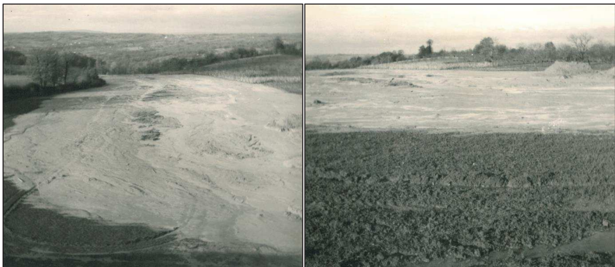
Figure 53 – Vue du champ situé à l'aval immédiat de la « digue » après la rupture [PLA-D-32]
