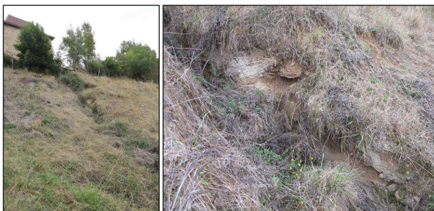
Figure 121 – Présence de résidus de traitement dans les berges du ruisseau de Roques issus de la coulée de 1966
