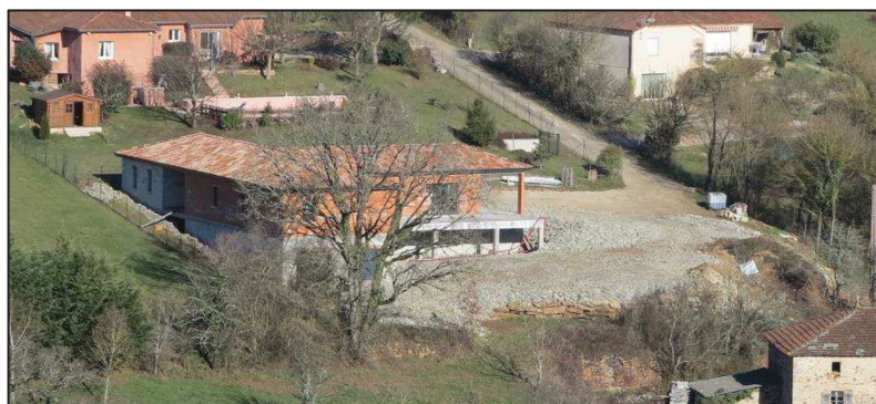
Figure 120 – Apport de remblai provenant très probablement de la halde de Fèges autour d'une habitation en construction (février 2019)
