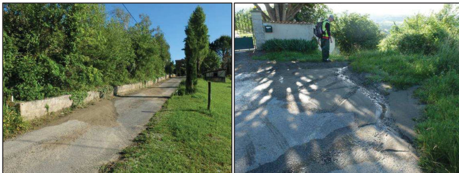
Figure 97 – Entraînement de matériaux de la « digue » n°1 par ruissellement lors de périodes de fortes précipitations sur la route des crêtes - Limite est et sud du dépôt (septembre 2018)
