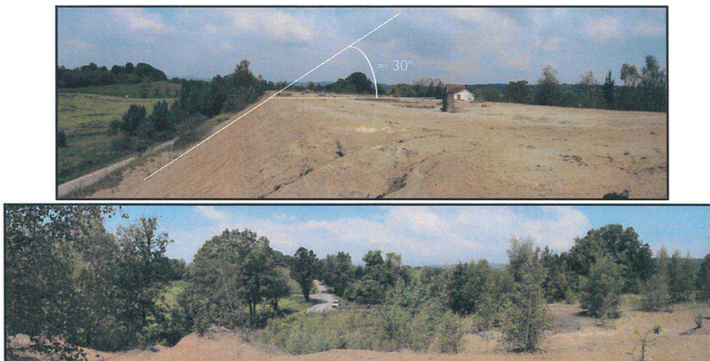
Figure 50 – Vues de la « digue » n°1 avant réhabilitation [PLA-UID-100]
