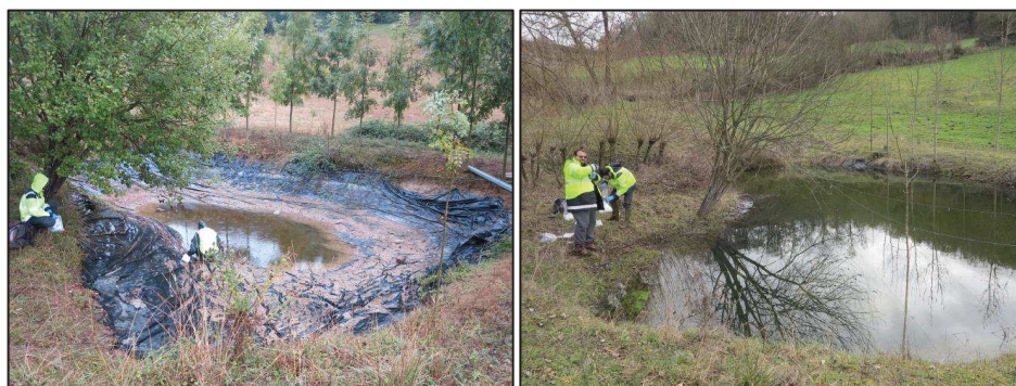
Figure 145 – Vues de l'étang E5 à Roques en étiage (sept. 2018) (à gauche) et en hautes eaux (fév. 2019) (à droite)
