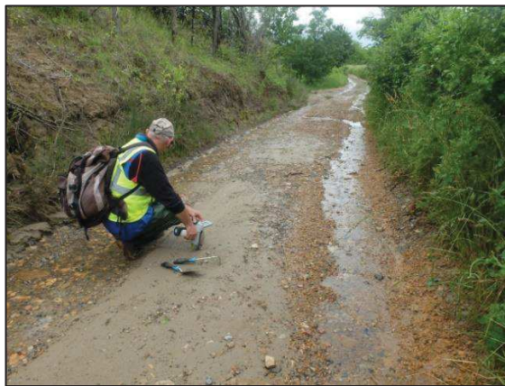
Figure 85 – Vue de ruissellement de fines sur le chemin qui longe la « digue » n°2 (septembre 2018)
