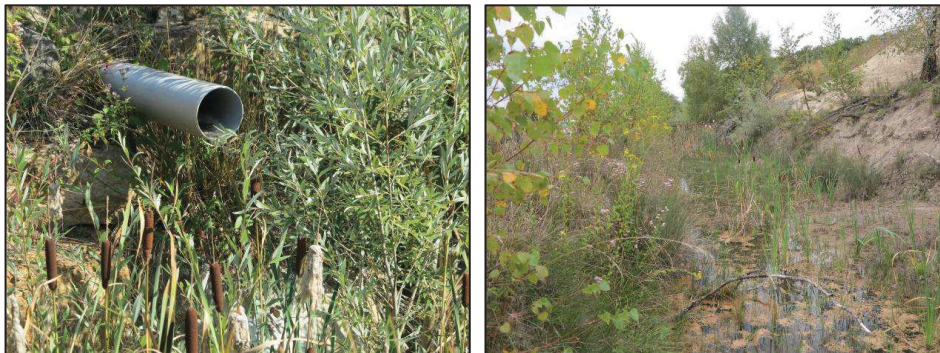
Figure 147 – Vues de l'exutoire de la « digue » n°2 à sec et vue de l'étang situé en pied de « digue » n°2 (septembre 2018)
