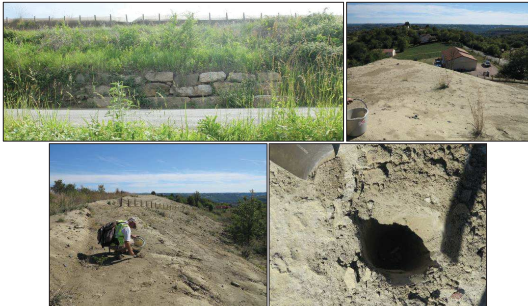
Figure 94 – Différentes vues de la « digue » n°1 et des résidus qui la composent
