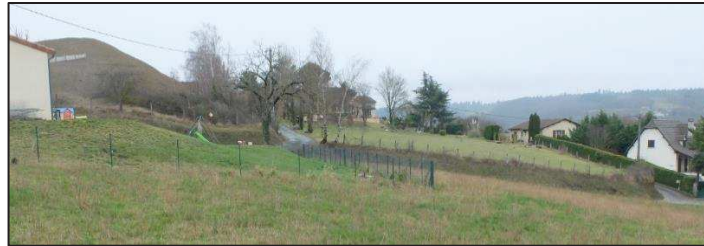
Figure 118 – Vue de la hauteur du dépôt par rapport aux habitations en contrebas, sous le vent (février 2018) à droite
