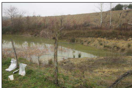
Figure 141 – Vue de l'étang E1 en pied de «digue» n°2
