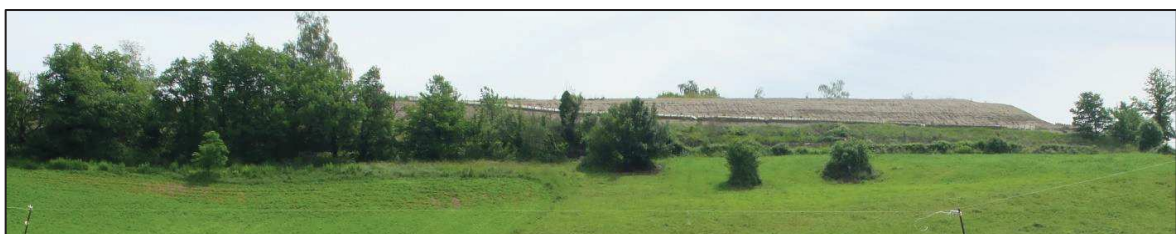
Figure 93 – Vue de la « digue » n°1
