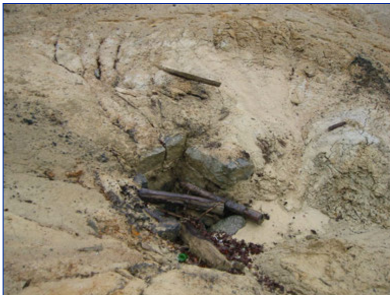
Photo 6 : Regard situé à l'aplomb du drain souterrain
