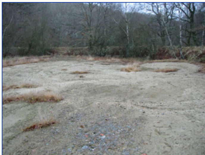
Photo 20 : Anciens bassins de décantation situés dans la partie aval du site
