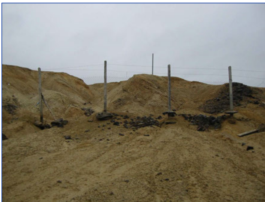
Photo 4 : Déchaussement de la clôture située sur les dépôts
