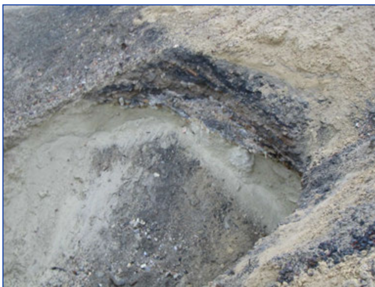
Photo 16 : Coupe verticale dégagée au niveau des résidus dans la zone de confluence des deux ruisseaux : on y devine des horizons de matériaux de couleur bleuâtre
