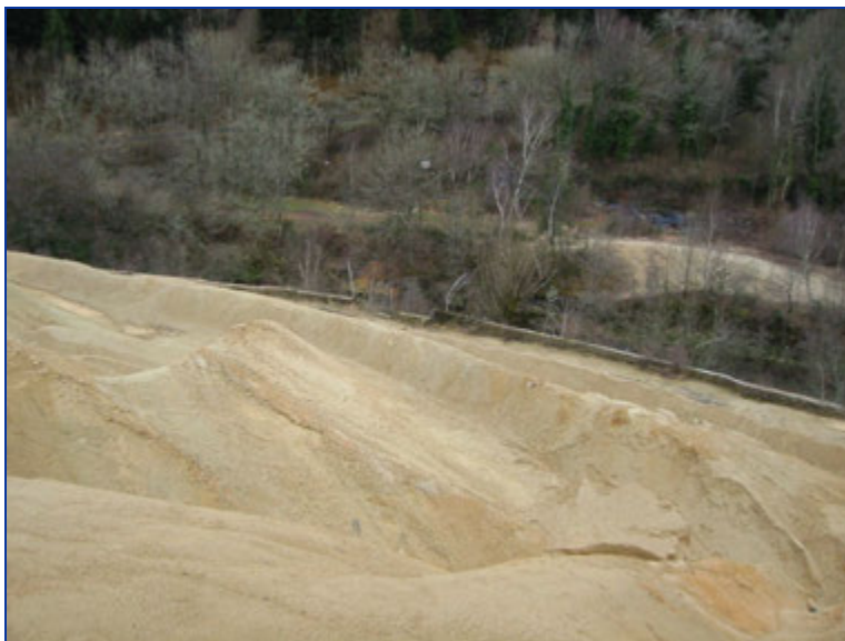
Photo 26 : Banquettes et fossés longitudinaux destinés à modifier le profil du tas
