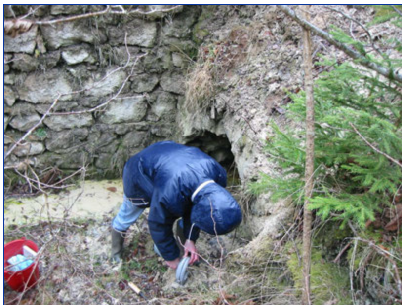
Photo 5 : Sortie du drain souterrain passant sous les dépôts
