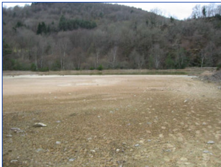
Photo 33 : Les bassins de décantation de Pranal
