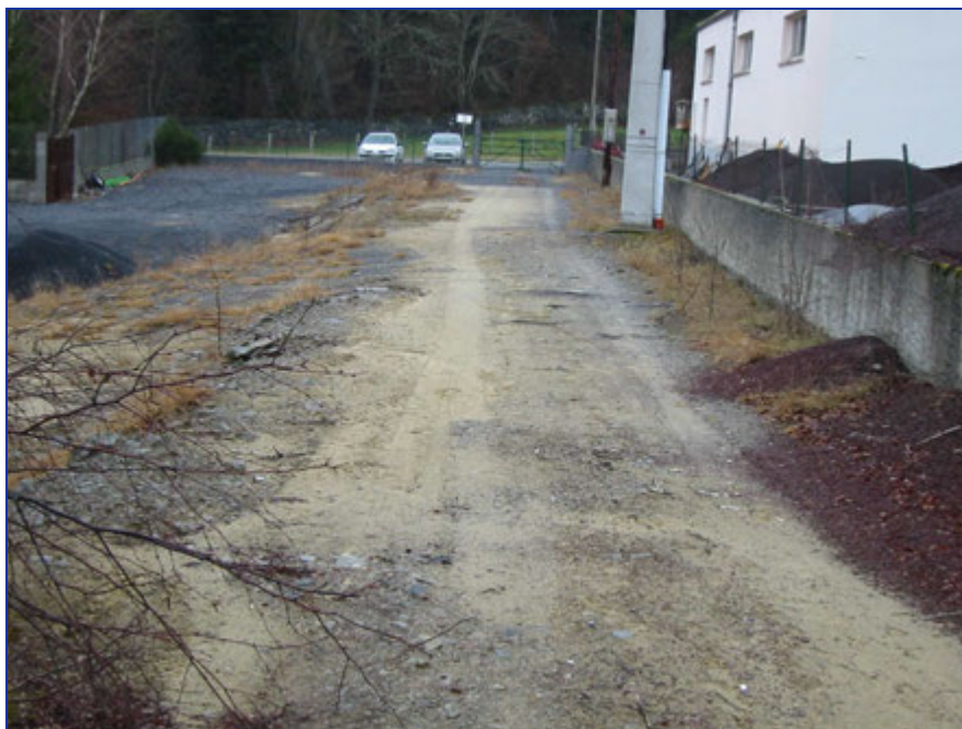
Photo 9 : Recouvrement du chemin par les résidus de laverie
