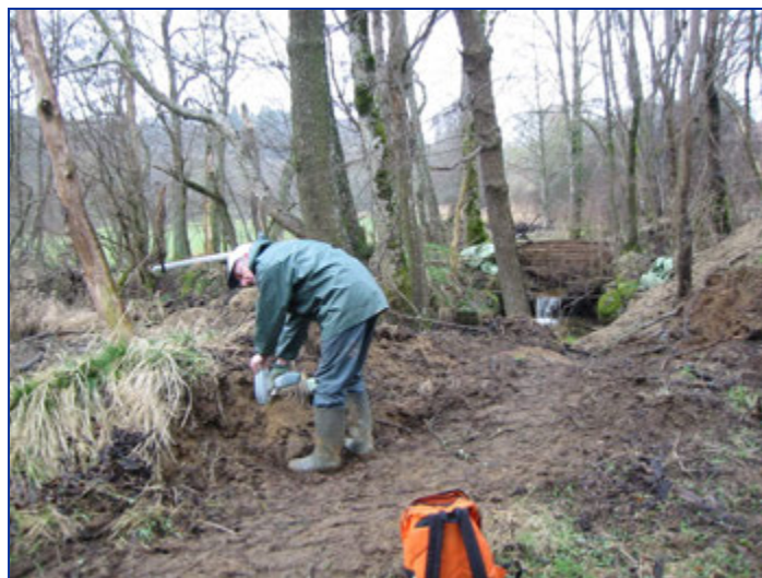
Photo 22 : Mesure effectuée en contre bas de la route sur un matériau issu du curage du ruisseau
