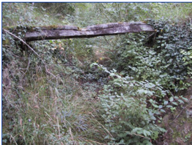
Photo 24 : Canal latéral creusé sur la bordure ouest du terril
