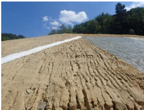
Illustration 143 : Filet accroche-terre et bandes drainantes en cours de pose.
