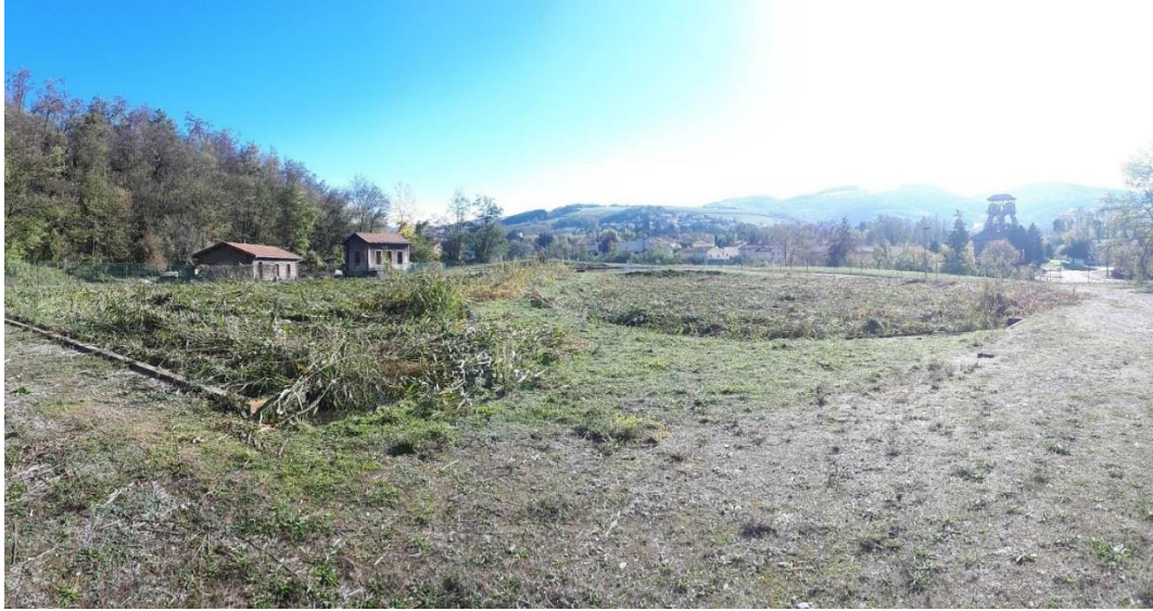
Illustration 28 : Station de traitement des eaux minières de Montrambert au Chambon-Feugerolles (42) - État des lagunes après les chutes de neige de fin octobre 2018.
