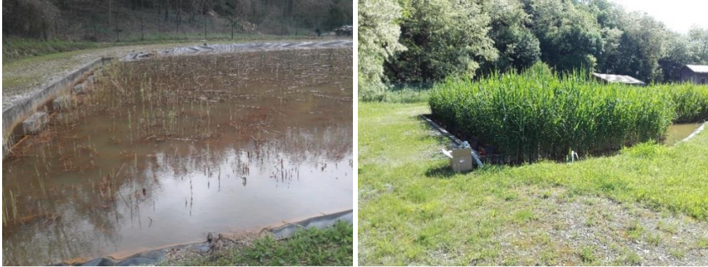
Illustration 29 : Station de traitement des eaux minières de Montrambert au Chambon-Feugerolles (42) – Repousse après faucardage des roseaux de la lagune n° 1, le 11 avril (à gauche) et le 25 mai (à droite).
