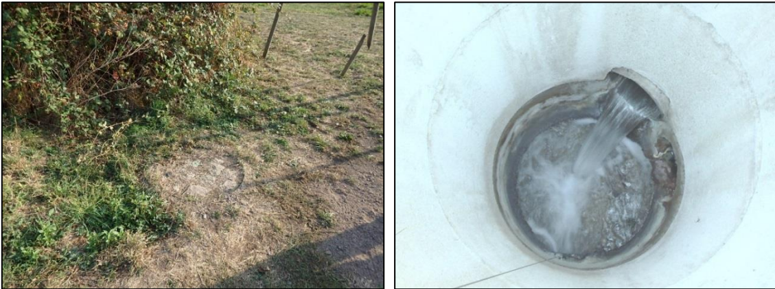
Illustration 24 : Émergence minière de la galerie Villars à Villars (42) - Regard d'accès à l'émergence minière (à gauche) et écoulements des eaux minières en fond de regard (à droite).
