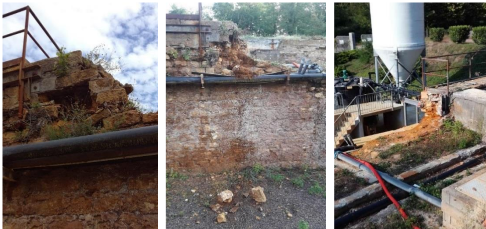
Illustration 79 : Station de traitement des eaux minières de Chessy-les-Mines (69) Muret avant (à gauche), après éboulement (au centre) et après travaux de sécurisation (à droite).
