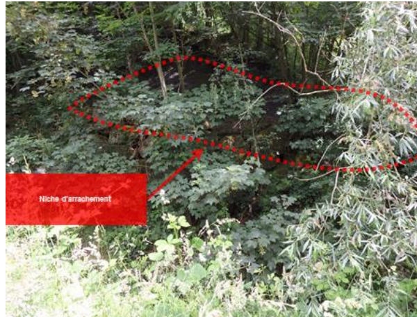
Illustration 53 : Dépôt de Côte Gravelle à Roche-la-Molière (42) - Niche d'arrachement répertoriée dans le talus nord.
