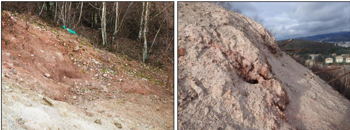
Illustration 37 : Terril Couriot B à Saint-Étienne (42) - crevasse (à gauche) et fissure d'échauffement (à droite) au niveau du rampant.
