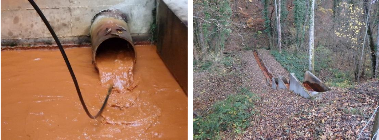
Illustration 10 : Susville - Émergences minières La Faurie et du forage de décharge (38) - Hydrocurage du drain de droite émergence minière La Faurie (à gauche) et nettoyage des bords du canal de l'émergence minière du forage de décharge (à droite).
