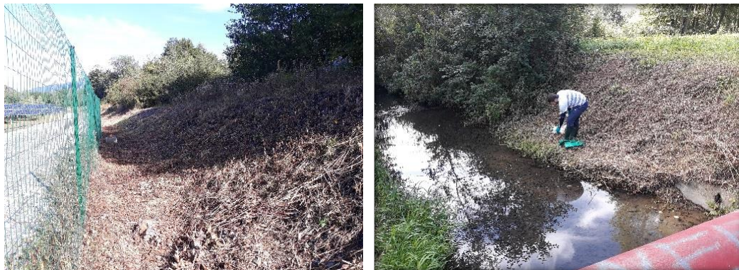
Illustration 9 : Susville - Étang des Moutières (38) - Nettoyage des accès aux piézomètres (à gauche) à ceux au point de contrôle de la Jonche (à droite).
