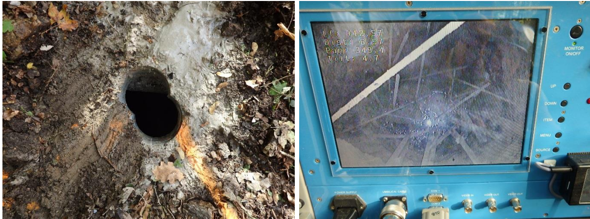
Illustration 73 : Mise en sécurité d'un puits de mine à Reventin-Vaugris (38) – dalle percée pour passage caméra (à gauche) vue des éléments métalliques obstruant l'ouvrage à 17,5 m de profondeur (à droite) .
