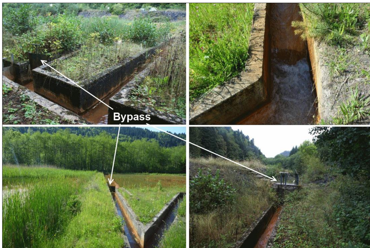
Illustration 119 : Messeix - Station des Mouillères - Les canaux de liaison et le système des bypass (2013).
