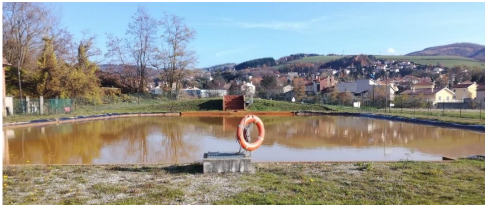
Illustration 26 : Station de traitement des eaux minières de Montrambert au Chambon-Feugerolles (42) - Vue générale du décanteur.
