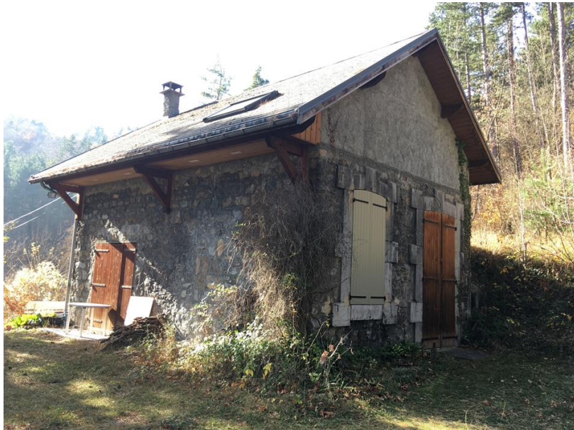
Illustration 15 : Susville (38) - Habitation individuelle constituant l'enjeu de surface vis-à-vis d'une galerie minière en mauvais état.
