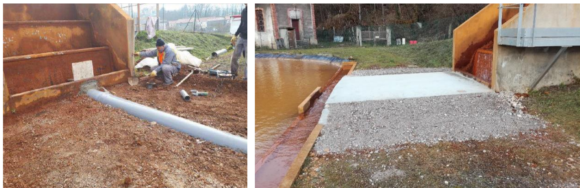
Illustration 31 : Station de traitement des eaux minières de Montrambert au Chambon-Feugerolles (42) – modification du caniveau de liaison cascade-bassin détérioré.
