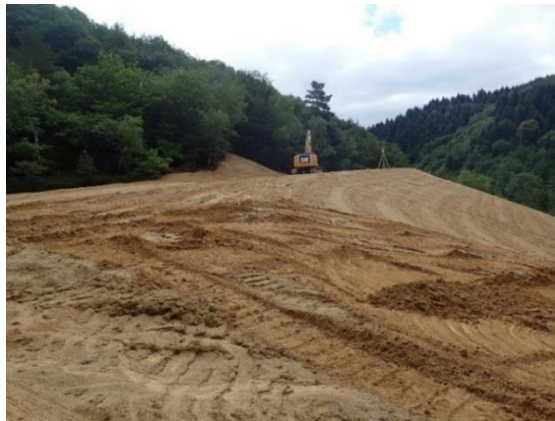
Illustration 141 : Travaux de reprofilage du dépôt de résidus miniers.
