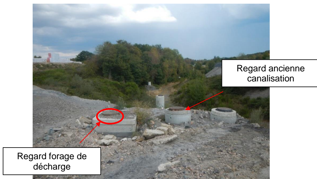
Illustration 130 : Saint-Éloy - Vue du forage de décharge et du regard de la canalisation sur l'usine Rockwool en 2018.
