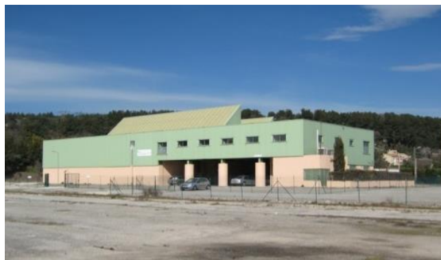
Illustration 2 : Bâtiment de l'UTAM Sud - Commune de Gardanne (13).
