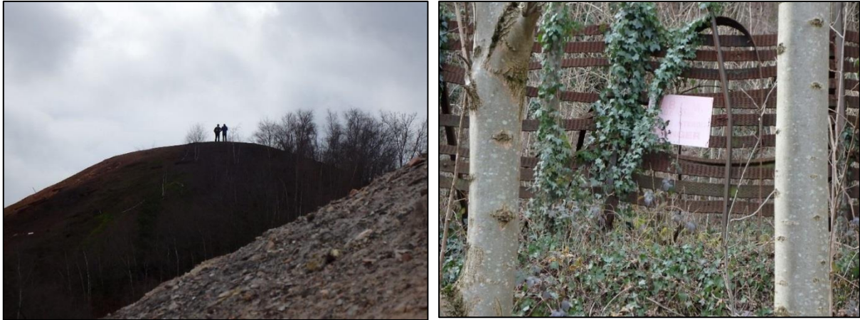
Illustration 38 : Terrils Couriot A et B à Saint-Étienne (42) – présence d'intrus au sommet du terril Couriot A en janvier 2018 (à gauche) et clôture et panneau en pied du terril Couriot B (à droite).
