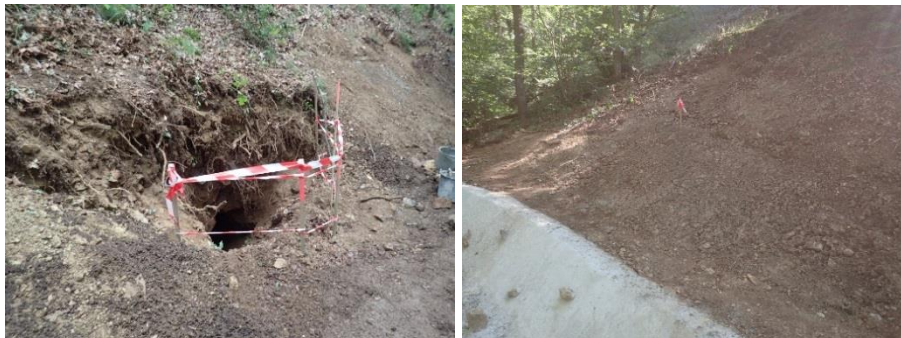
Illustration 147 : Ouvrage débouchant au jour avant et après traitement.
