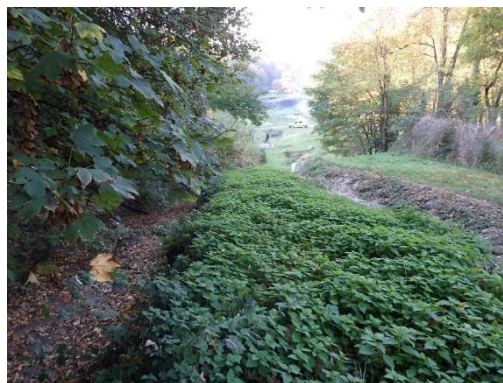
Illustration 52 : Dépôt de Côte Gravelle à Roche-la-Molière (42) - Buses du caniveau nord.
