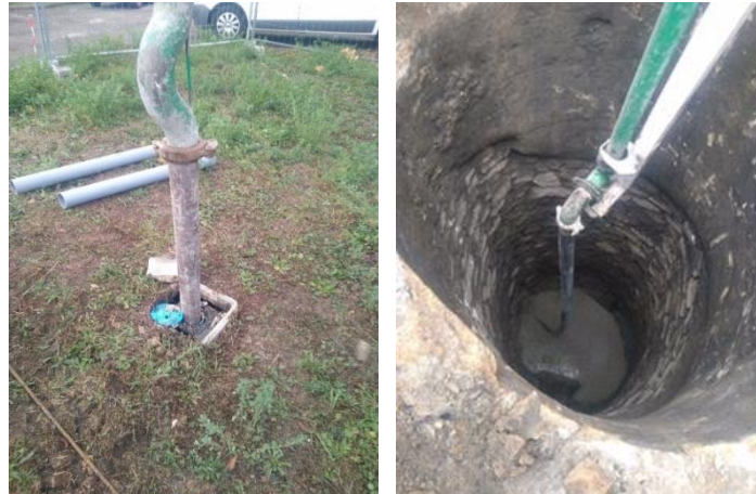
Illustration 56 : Fontis du Puits des Échelles à Rive-de-Gier (42) – Injection de béton pour combler les vides périphériques (à gauche) - confection du « bouchon autoportant » dans le puits (à droite).
