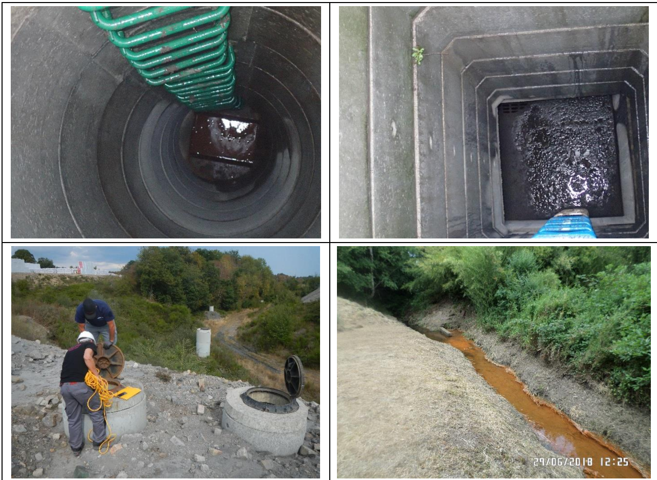
Illustration 131 : Saint-Éloy – Vue de l'écoulement des eaux dans les regards du forage de décharge et de la canalisation de la Vernade et à la sortie de la canalisation (2018).
