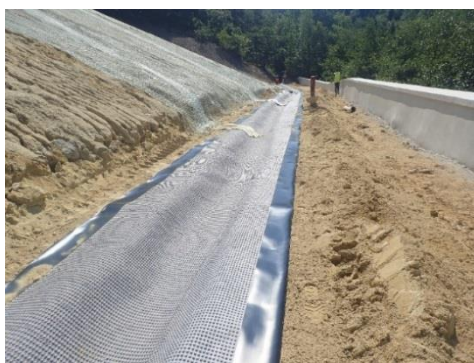
Illustration 144 : Géocomposite posé dans les fossés de risberme.
