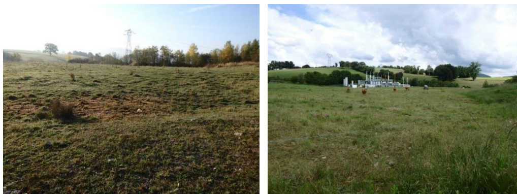
Illustration 50 : Dépôt de cendres de Côte Gravelle à Roche-la-Molière (42) - Point bas en partie sommitale montrant des signes d'accumulation d'eau (à droite) et pacage de vaches (à gauche).
