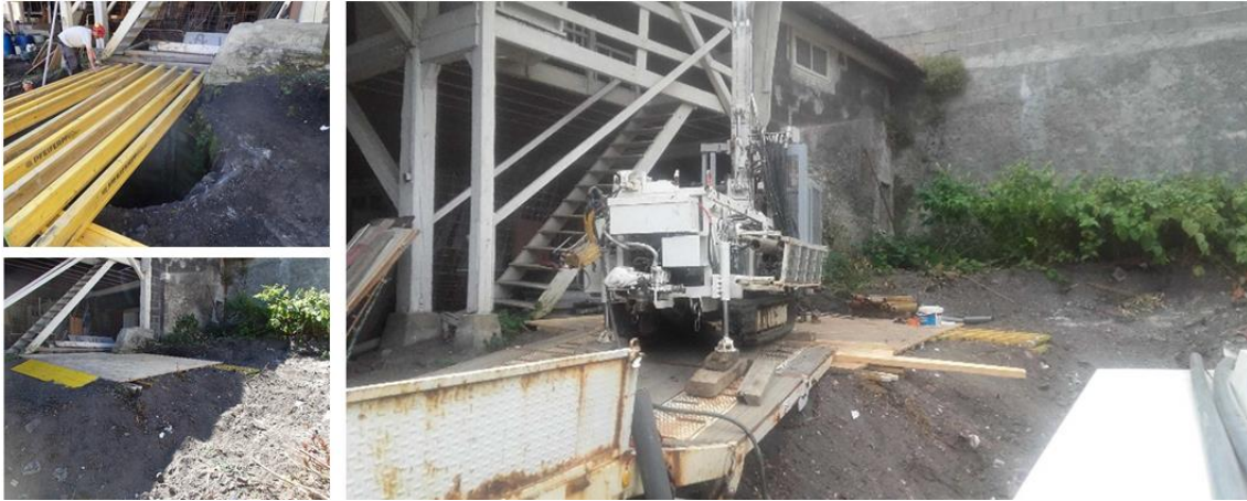
Illustration 60 : Mise en sécurité de la tête du puits Moïse à Rive-de-Gier (42) - Confection d'un platelage au-dessus de l'ancien puits de mine (à gauche haut et bas) pour amener la sondeuse au droit du puits (à droite).
