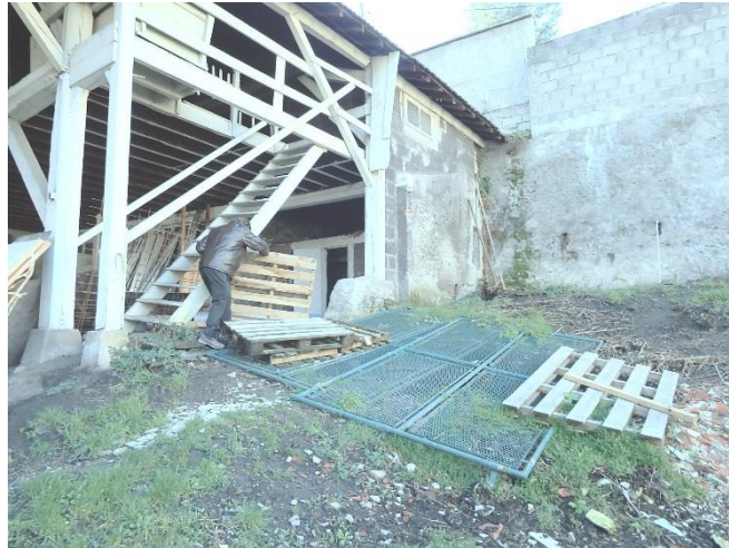
Illustration 59 : Mise en sécurité de la tête du puits Moïse à Rive-de-Gier (42) - Protection provisoire du puits débourré.
