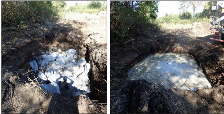
Illustration 96 : Puits du Grand-Manège, bouchon de surface.
