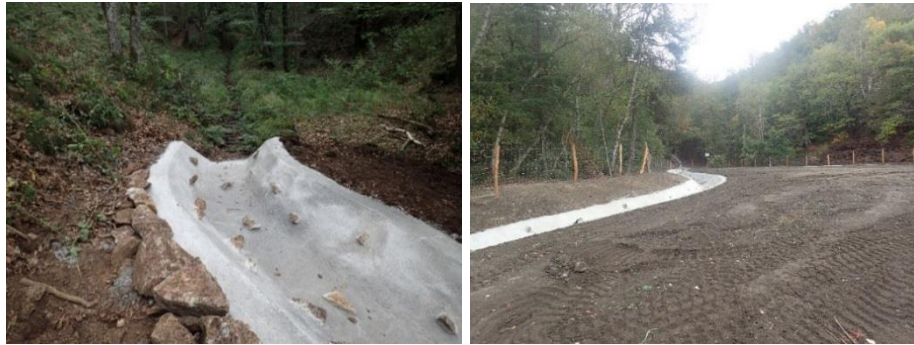
Illustration 146 : Partie supérieure du fossé A avec raccordement au fossé amont existant dans le terrain naturel et partie aval du fossé A.
