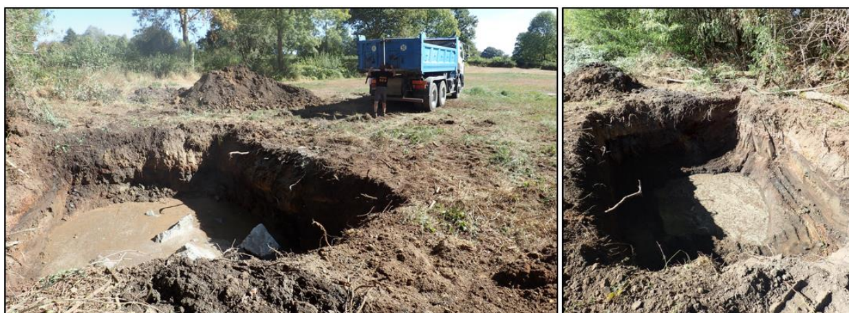
Illustration 95 : Puits du Grand-Manège, excavation de la tête du puits.
