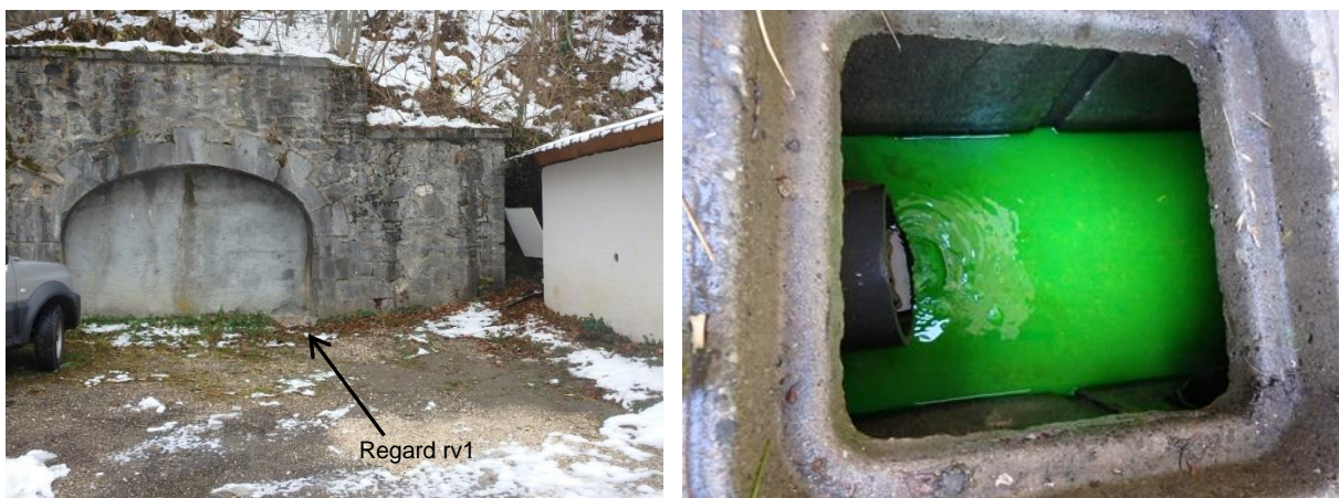
Illustration 8 : Émergence minière de la galerie Psychagnard N9 à Susville (38) - Entrée condamnée de la galerie minière (à gauche) et injection de fluorescéine dans regard (à droite).
