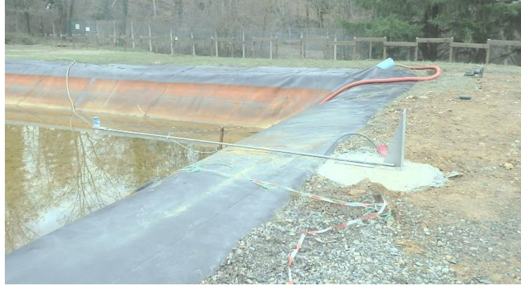
Illustration 83 : Station de traitement des eaux minières de Chessy-les-Mines (69) - Sonde de niveau du bassin de rétention.
