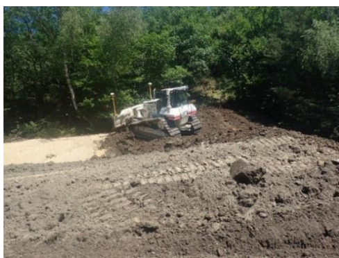
Illustration 145 : Régalage de terre végétale au Bulldozer.
