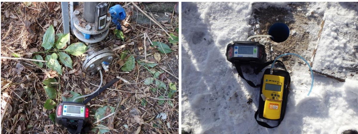
Illustration 14 : Plateau Matheysin Susville – La-Motte-d'Aveillans (38) – mesures des gaz dans ouvrages à aménager.
