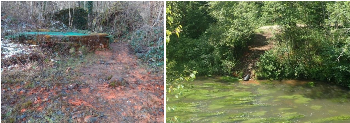
Illustration 133 : Vue de l'exutoire du puits Sainte-Barbe et du point de rejet dans la Sioule (2018).
