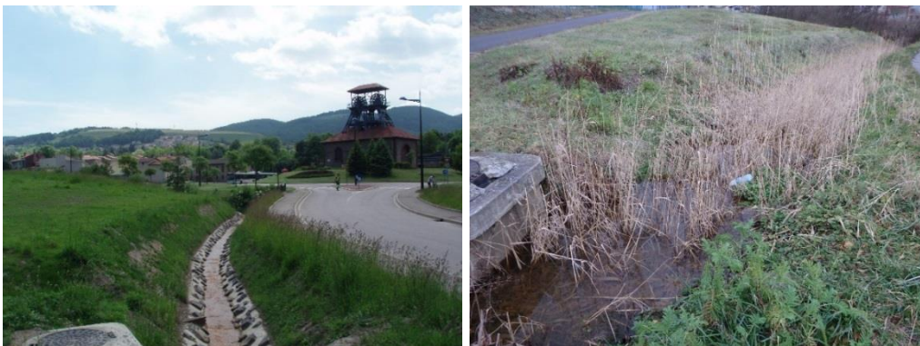
Illustration 30 : Station de traitement des eaux minières de Montrambert au Chambon-Feugerolles (42) – Fossé d'évacuation des eaux minières traitées, état en 2009 (à gauche) et en 2018 avant l'opération de curage (à droite).
