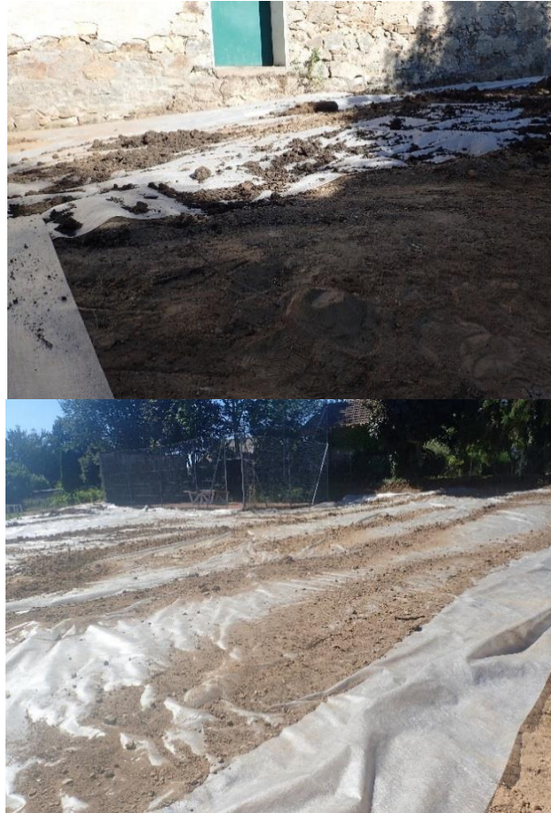
Illustration 114 : Pose du géotextile après décapage sur les zones 1a et 5.
