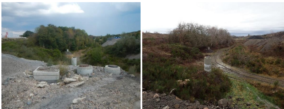
Illustration 128 : Saint-Éloy - Travaux de la canalisation de la Vernade en 2018.
