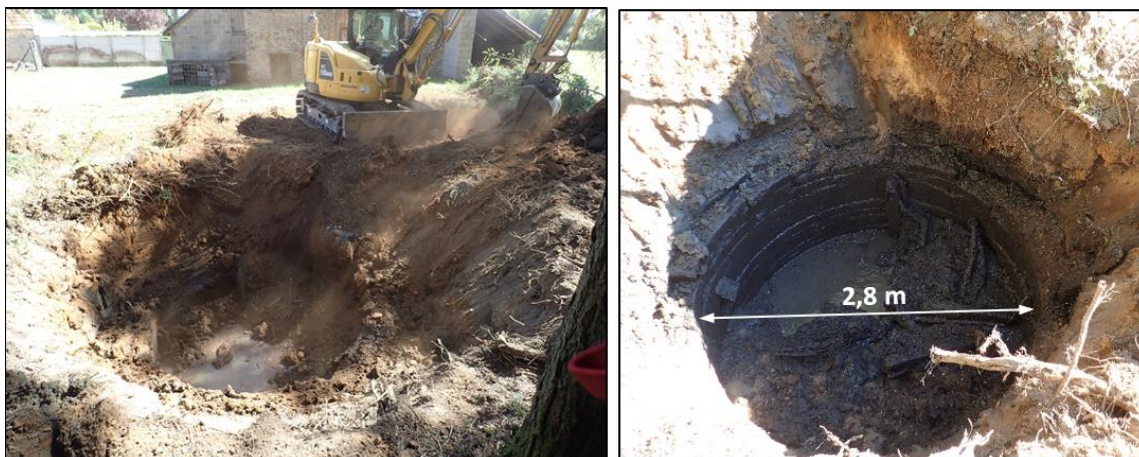
Illustration 93 : Puits Saint-Charles, excavation de la tête du puits.
