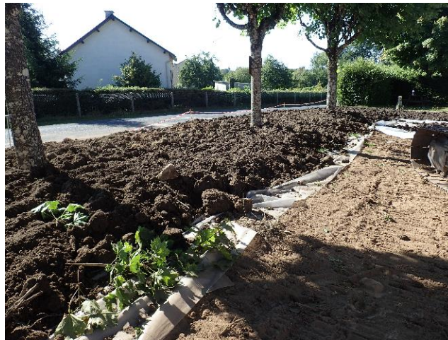
Illustration 115 : Zone 5 - mise en place d'une couverture de terre recouvrant le géocomposite.
