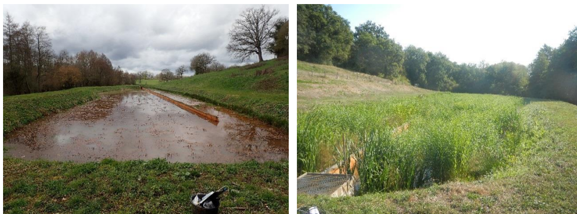
Illustration 106 : Buxières - Reprise des roseaux la lagune 1 (mars 2018, photo de gauche, septembre 2018, photo de droite).
