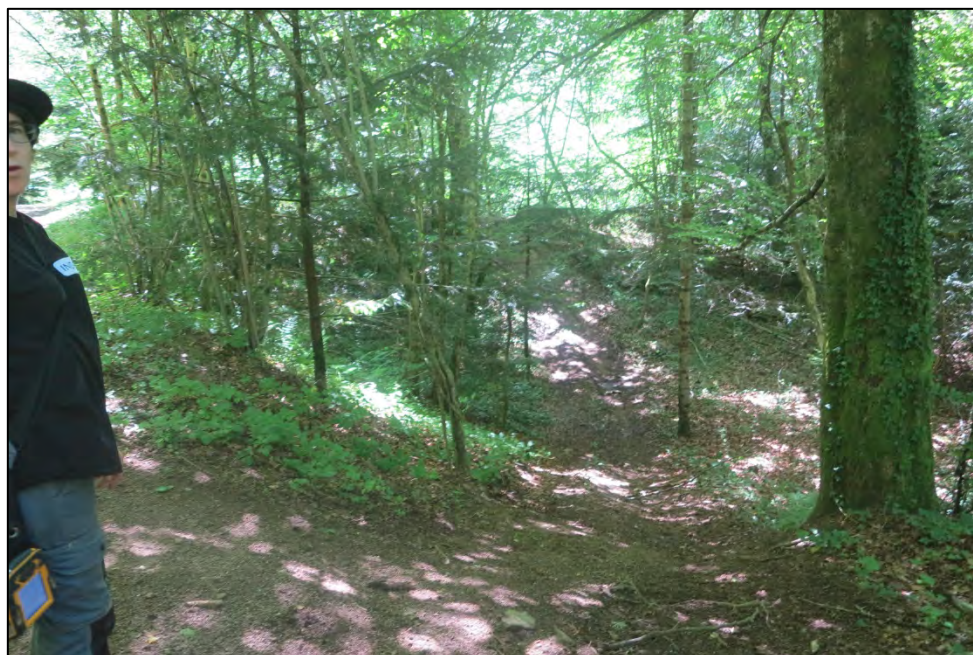
Figure 94 : Site de Corent - Digue érodée par les engins tout-terrain
