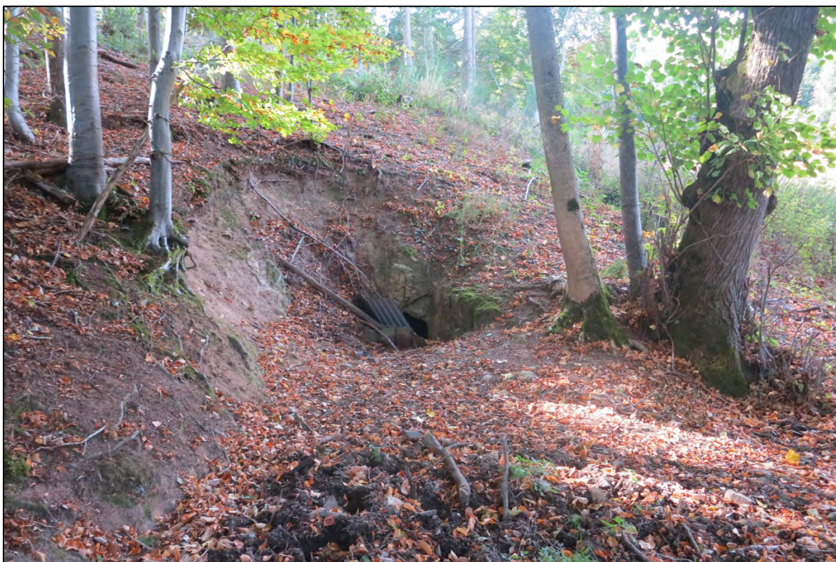
Figure 130 : Site de Grandris - Galerie avec résurgence
