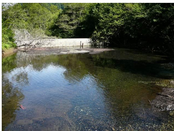
Vue du barrage en aval du carreau 1230
