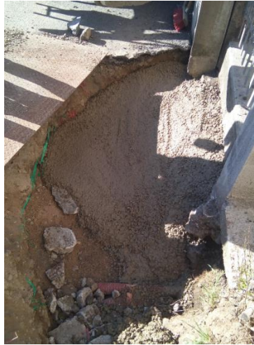
Illustration 39 : Comblement du vide par du béton autoplaçant - Branoux-les-Taillades (30).
