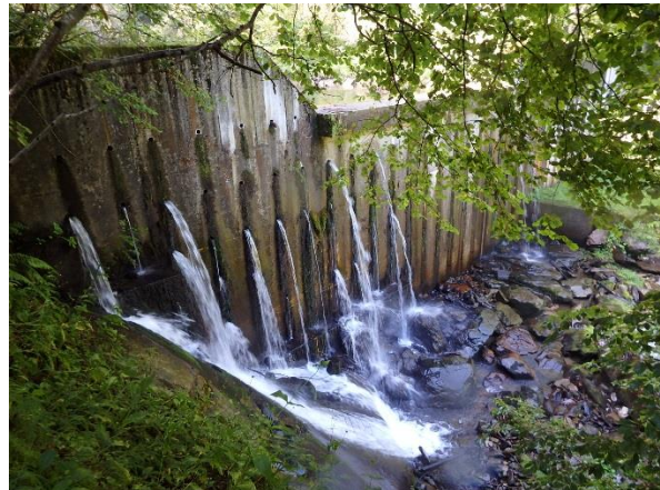
Illustration 129 : Ancienne mine de tungstène de Salau (09) : Barrage des Cougnets – Vues du plan d'eau (à gauche) et de la face aval du barrage avec écoulements par les barbacanes (à droite) septembre 2018.
