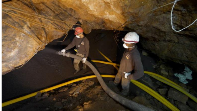
Illustration 81 : Déversement de billes d'argile expansée - Le Pradal (34).
