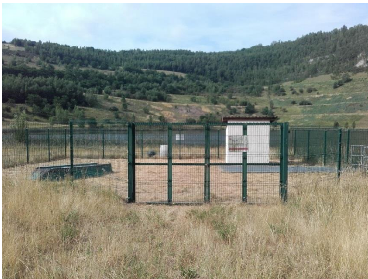
Illustration 93 : Station de pompage du lac Lassalle à Decazeville (12) - Vue de la station de pompage avec lac en arrière plan.
