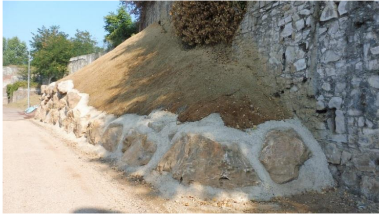
Illustration 19 : Station de Destival – Sécurisation du merlon de confortement - Saint-Martin-de-Valgalgues (30).
