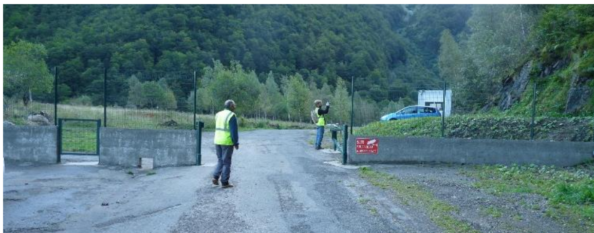
Illustration 124 : Ancienne mine de tungstène de Salau (09) : Ancien carreau 1230 – Clôture et portails d'accès.
