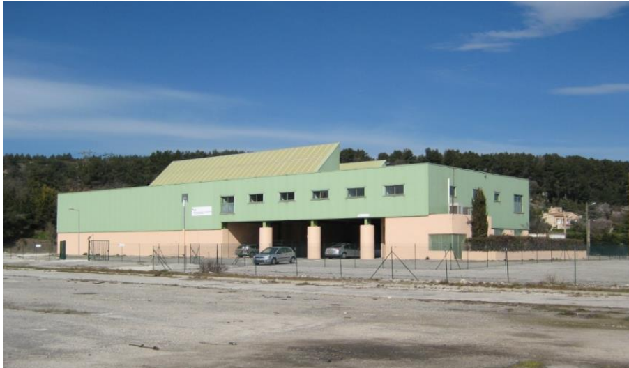
Illustration 2 : Bâtiment de l'UTAM Sud - Commune de Gardanne (13).
