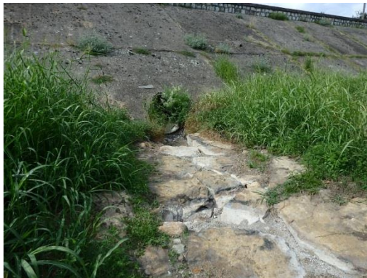
Illustration 28 : Émergence de la Galerie Saint-Pierre : absence de venue d'eau - Alès (30).
