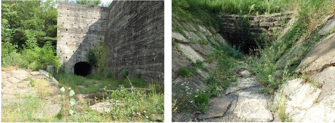
Illustration 30 : Plan Incliné des Oules : chenal entre la sortie de la galerie et le déversoir dans le ruisseau couvert - Commune de Laval-Pardel (30).
