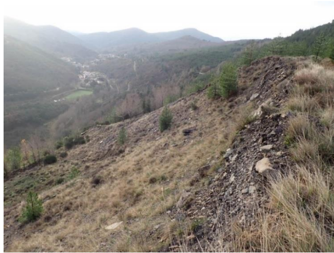
Illustration 51 : Verse des Brouttes - Exhumation de blocs en tête de la couronne d'arrachement - Camplong (34).
