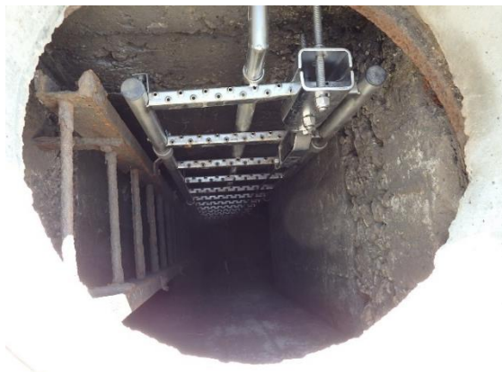
Illustration 24 : Émergence Verrerie – Nouvelle échelle d'accès mise en place (nb : l'ancienne échelle n'avait pas encore été déposée lors du contrôle de septembre) - La Grand'Combe (30).
