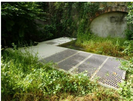
Illustration 23 : Émergence Chalmeton : grille recouvrant le bassin récepteur aménagée avec une trappe d'accès – Molière-sur-Cèze (30).
