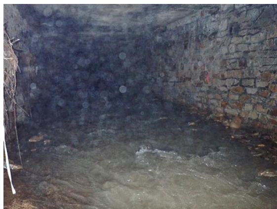
Illustration 25 : Émergence du Mas-Blanc – Galerie du ruisseau Sans-Nom ayant un débit trop important pour rejoindre le point de contrôle - La Grand'Combe (30).
