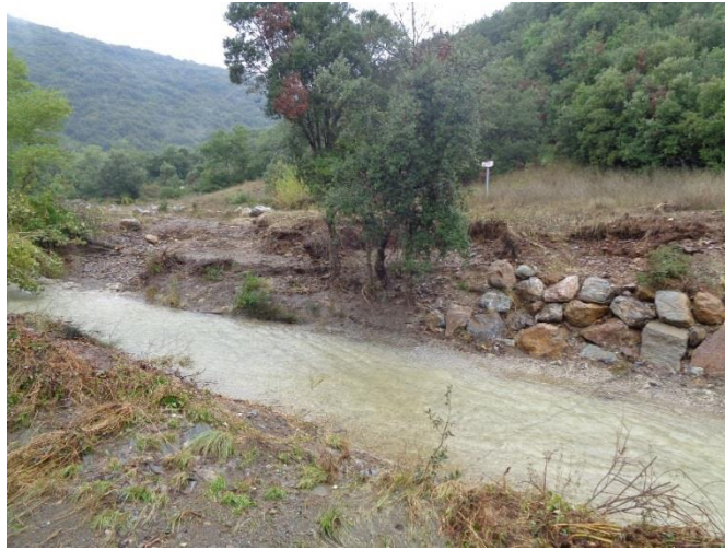
Illustration 63 : Site de Nartau – Protection de la plateforme Marty, en partie emportée par la crue d'octobre - Villanière (11).
