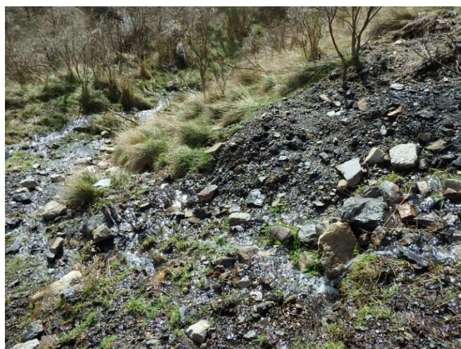
Illustration 53 : Verse des Brouttes - Persistance d'un renard liquide en partie basse de la verse - Camplong (34).
