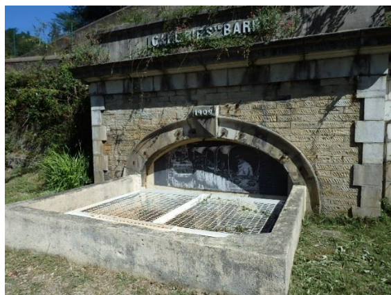
Illustration 26 : Émergence Sainte-Barbe : grille de protection du bassin récepteur - La Grand'Combe (30).
