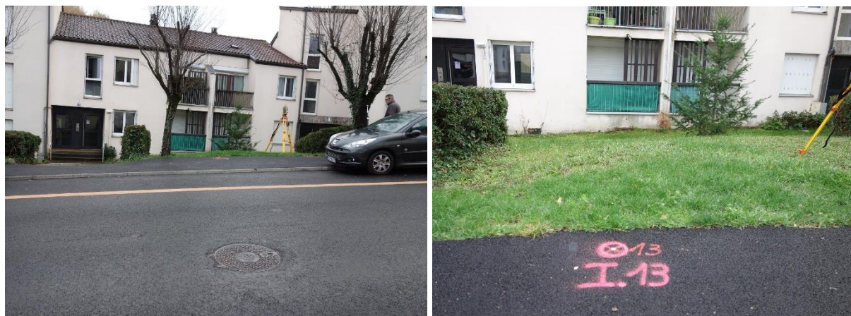
Illustration 137 : Mine de fer de Lagrange à Decazeville (12) : finalisation du réseau de nivellement - implantation du repère altimétrique DECAZ 13 (à gauche), « clou d'arpentage » (à droite).
