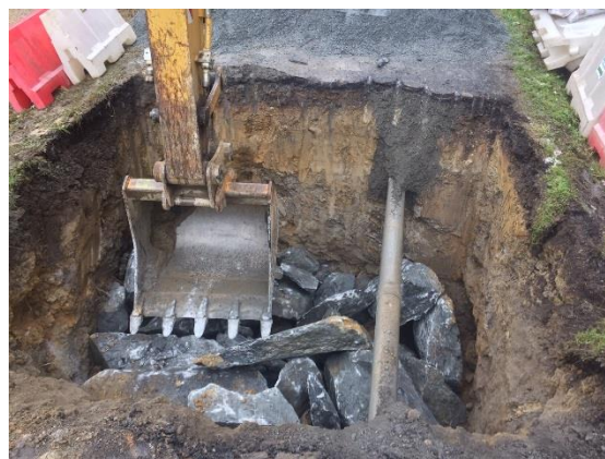
Illustration 118 : Fontis sous la RD 513 au lieu-dit « la Gouzinie » à Aubin (12) – traitement du fontis.
