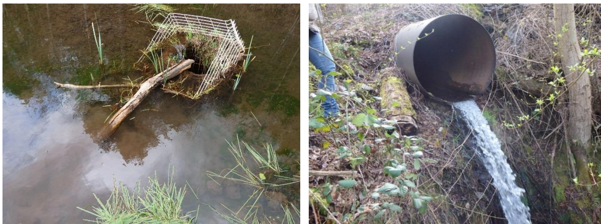
Illustration 112 : Dépôt de Joany à Viviez (12) - Avaloir vandalisé du réseau hydraulique souterrain au centre du bassin de collecte des eaux des Vallons du Puech et de Coupel (à gauche) et buse de sortie du réseau dans le vallon de Joany (à droite).
