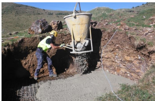
Illustration 78 : Batère – Bétonnage de la dalle de fermeture du puits B14 - Corsavy (66).
