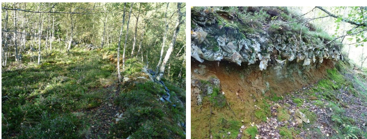
Illustration 128 : Ancienne mine de tungstène de Salau (09) : végétalisation du sommet du bassin n° 3 (à gauche) et pied de la digue du bassin n° 4 avec sous-cavage (à droite).
