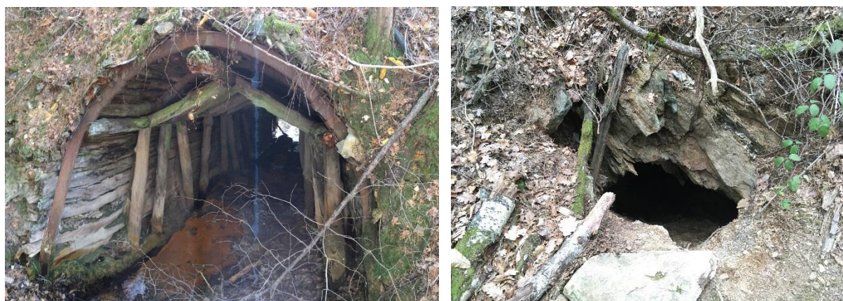
Illustration 141 : Ancienne mine de tungstène d'Engualès au Fel (12) – Ancien tunnel (à gauche) et fontis dans la pente (à droite).
