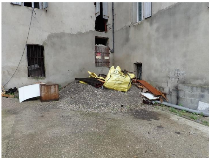
Illustration 29 : Émergence Nationale : point de contrôle recouvert par des matériaux - Saint-Martin-de-Valgalgues (30).
