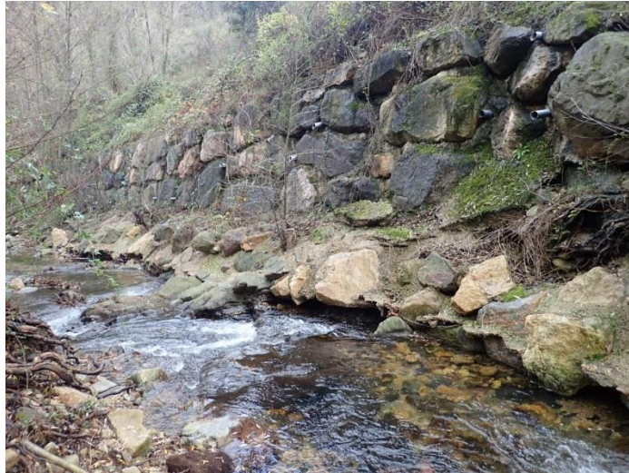
Illustration 54 - Phénomènes d'affouillement au pied de la Verse des Brouttes - Camplong (34).
