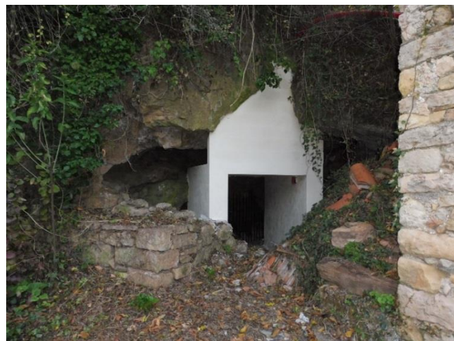
Illustration 84 : Travaux de sécurisation de l'entrée de la mine de Taussac-la-Billière (34).
