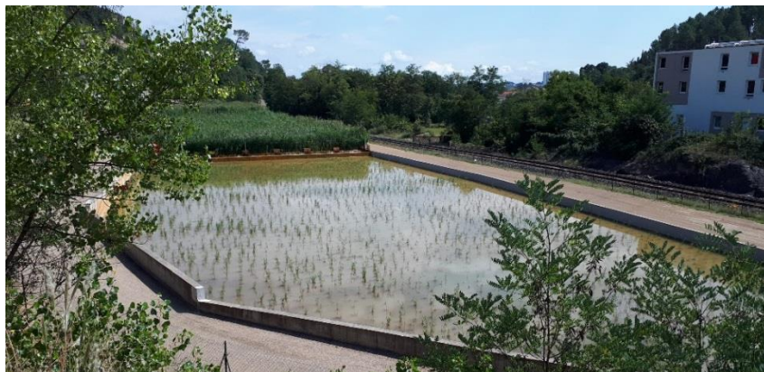
Illustration 7 : Station de traitement des eaux de Destival - Vue dans la lagune L3 des jeunes roseaux en septembre après remise en eau - Commune de Saint-Martin-de-Valgalgues (30).
