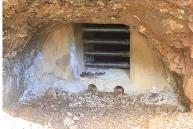
Illustration 79 : Batère – Fermeture de la galerie B10 à l'aide d'une chiroptière - Corsavy (66).
