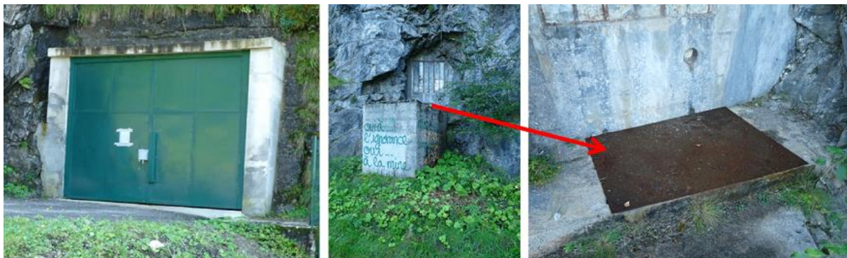
Illustration 130 : Ancienne mine de tungstène de Salau (09) : entrée de l'ancienne mine souterraine (à gauche) et regard d'accès à l'émergence minière 1230 (au centre) avec plaque verrouillée (à droite) en septembre 2018.
