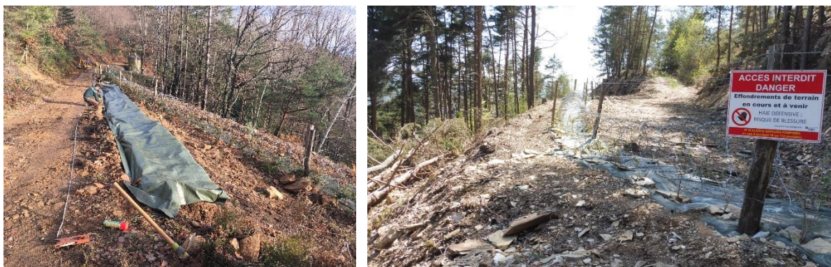
Illustration 138 : Ancienne mine de tungstène d'Engualès au Fel (12) – doublement de la clôture végétale sur une cinquantaine de mètres suite à une erreur de positionnement (à gauche) panneaux d'information sur les risques (à droite).
