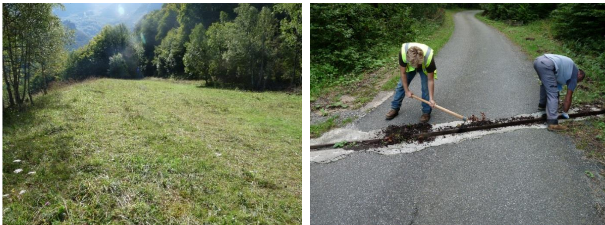
Illustration 120 : Ancienne mine de tungstène de Salau (09) : plateforme sommitale de la verse 1150 (à gauche), nettoyage du caniveau en travers de la chaussée (à droite) en septembre 2018.
