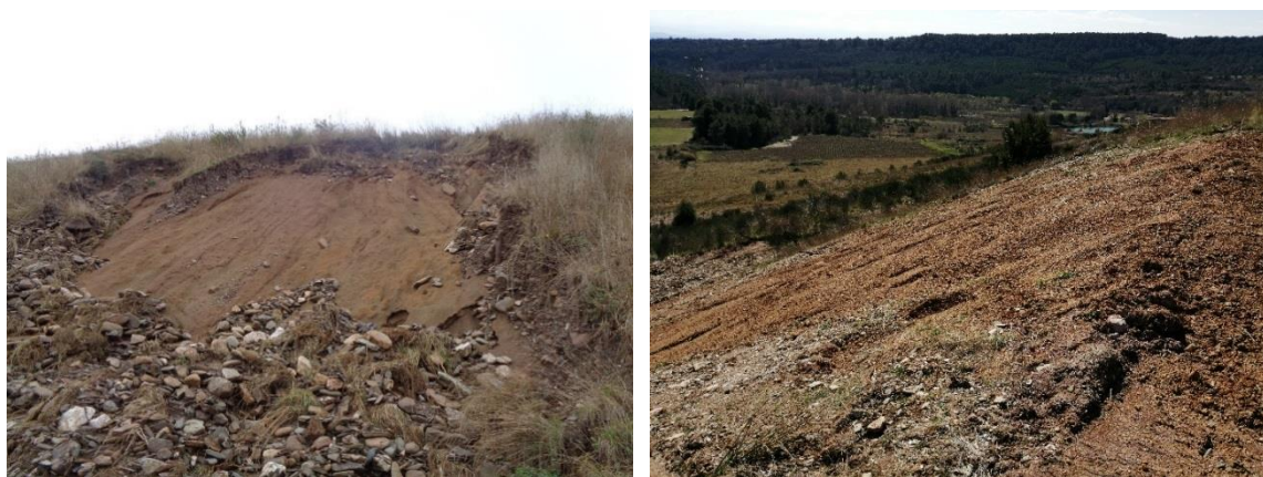
Illustration 68 : Glissement superficiel sur l'Artus après les intempéries d'octobre 2018 – à gauche : avant traitement – à droite : après traitement - Salsigne (11).
