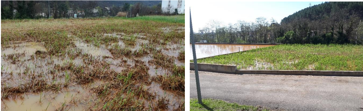
Illustration 13 : Station de Destival – Lagune n° 1 après faucardage - Saint-Martin-de-Valgalmes (30).
