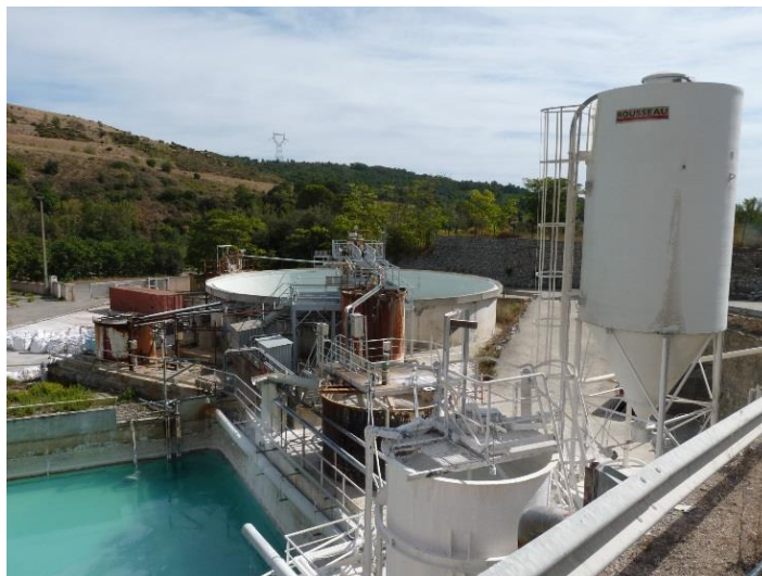
Illustration 74 : Vue de la station de traitement de la Combe-du-Saut - Limousis (11).
