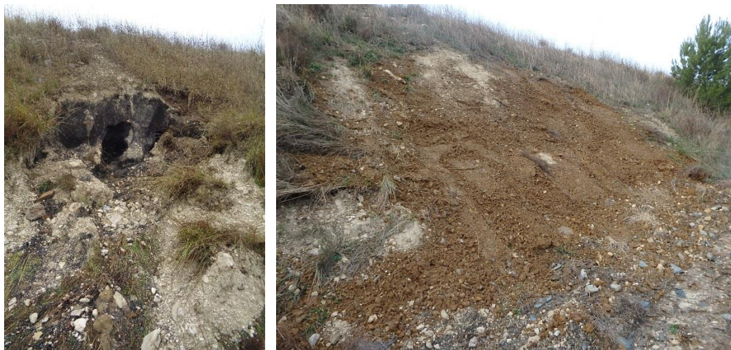
Illustration 67 : Renard hydraulique dans le flanc Sud de Montredon après intempéries d'octobre 2018 – à gauche : avant traitement – à droite : après traitement - Salsigne (11).
