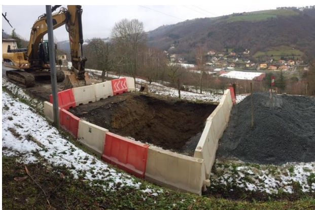
Illustration 118 : Fontis sous la RD 513 au lieu-dit « la Gouzinie » à Aubin (12) – traitement du fontis.
