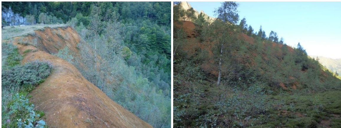
Illustration 126 : Ancienne mine de tungstène de Salau (09) : verse 1230 - Partie sommitale petit merlon de crête à nu (à gauche) et partie sud du talus (à droite).
