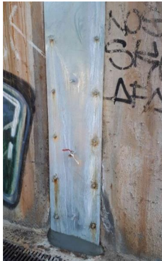
Illustration 14 : Station de Destival – Traitement par l'extérieur des joints de la lagune n° 1 - Saint-Martin-de-Valgalmes (30).
