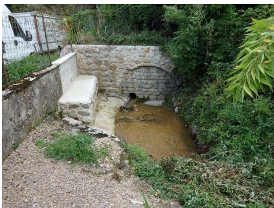
Illustration 21 : Émergence Plan : vue du mur de fermeture après travaux - Le Martinet (30).
