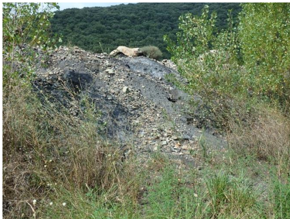
Illustration 35 : Ravinement sur le flanc Ouest du fossé des Oules, et mise à nu de schlamms - Laval-Pradel (30).
