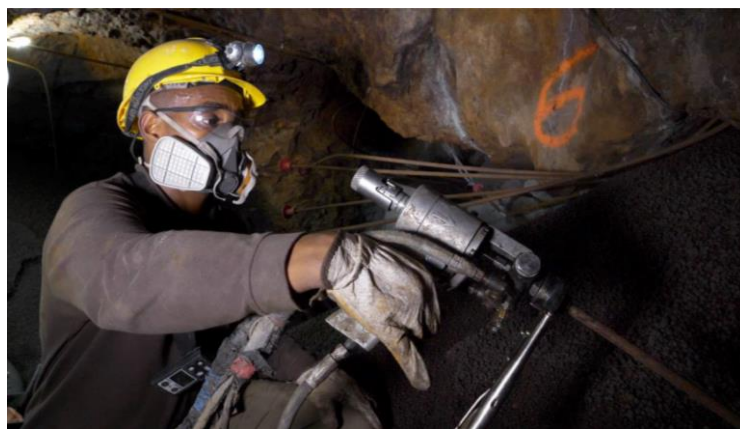
Illustration 82 : Clavage par résine expansive - Le Pradal (34).
