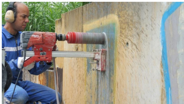
Illustration 15 : Station de Destival – Carottage béton dans le voile d'une des lagunes - Saint-Martin-de-Valgalmes (30).
