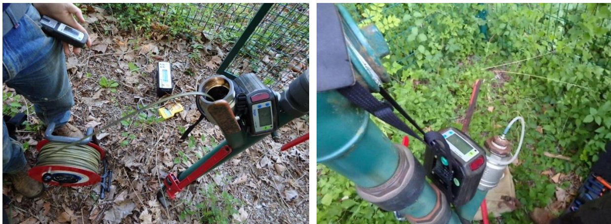
Illustration 111 : Exécutoires « gaz » - mesure piézométrique (à gauche) et mesure des « gaz » dans le sondage de décompression Cantaranne 1 à Cransac (à droite).
