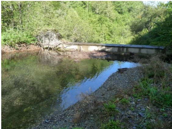
Illustration 129 : Ancienne mine de tungstène de Salau (09) : Barrage des Cougnets – Vues du plan d'eau (à gauche) et de la face aval du barrage avec écoulements par les barbacanes (à droite) septembre 2018.
