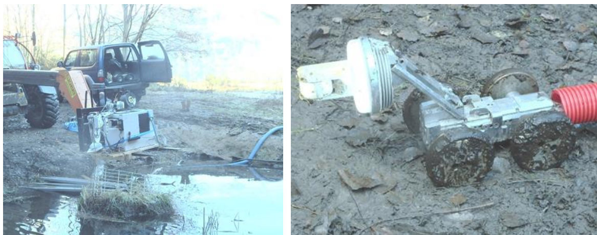
Illustration 116 : Dépôt de Joany à Viviez (12) - réseau hydraulique souterrain – investigation canalisation par vidéo-caméra – installation du matériel (à gauche) et robot vidéo-caméra (à droite)
