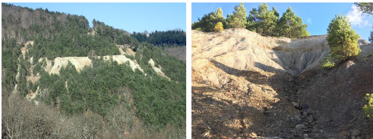
Illustration 140 : Ancienne mine de tungstène d'Engualès au Fel (12) – Dépôt de résidus principal vues générale (à gauche) et de détail (à droite).
