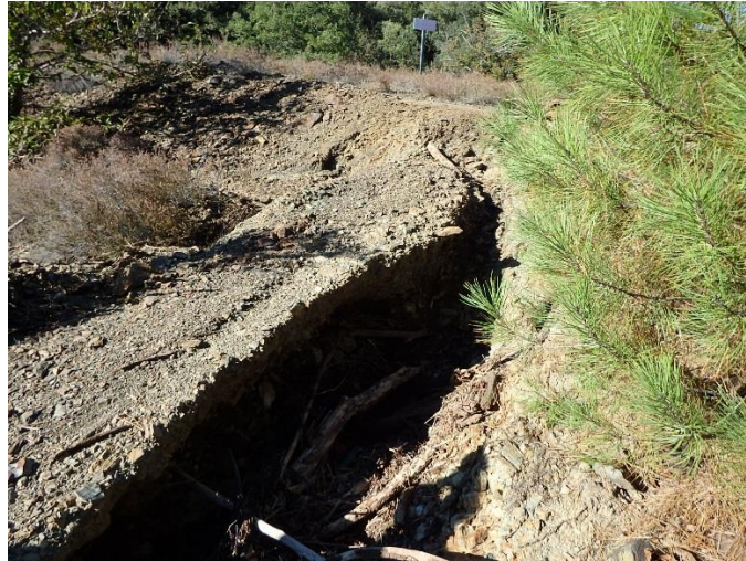
Illustration 65 : Site de Malabau – Ravinement - Salsigne (11).
