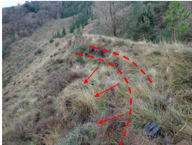
Illustration 52 : Verse des Brouttes – Glissement superficiel en tête de la digue piège à blocs - Camplong (34).
