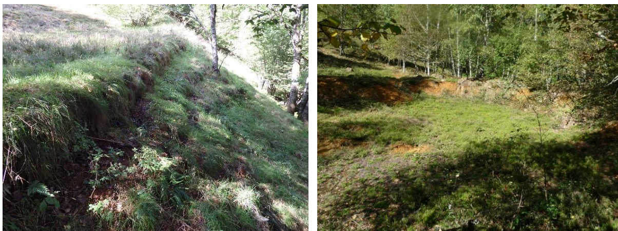
Illustration 123 : Ancienne mine de tungstène de Salau (09) : pied de la verse 1150 - Digue de contention du bassin nord (à gauche) et état de la fosse centrale (à droite).
