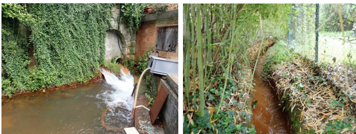
Illustration 43 :TB Grand-Champ - À gauche : vue des 2 exutoires - À droite : berges du canal de rejet nettoyées par la commune - Graissessac (34).
