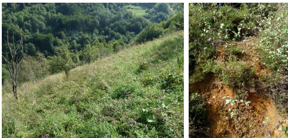
Illustration 121 : Ancienne mine de tungstène de Salau (09) : talus de la verse 1150 (à gauche) avec zone de renards hydrauliques dans la pente (à droite) en septembre 2018.
