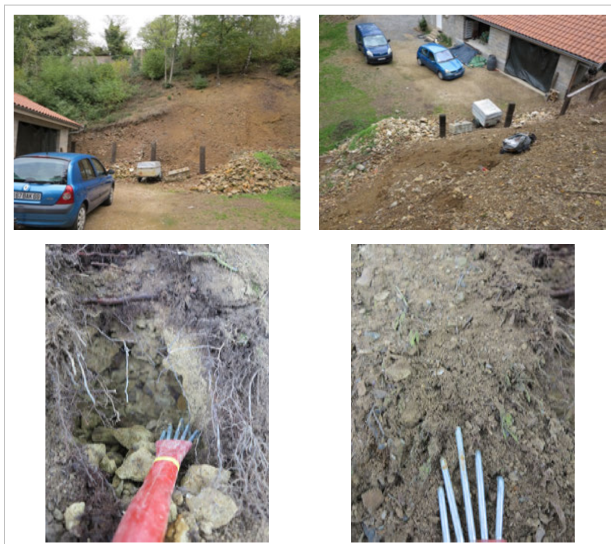
Figure 22 : Extension Sud-Est du dépôt minier principal (Photos : GEODERIS, 2015)
