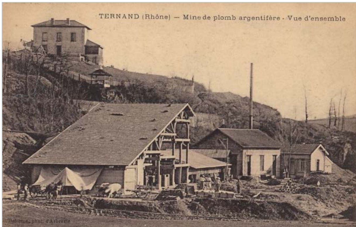
Figure 12 : Carreau de la mine de Ternand, vue vers le Sud. Carte postale non datée ; Delorme, phot. L'Arbresle. [Source : www.delcampe.net ]
