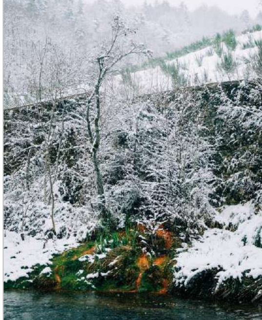
Dépôt de résidus miniers mis en sécurité et ruissellement en pied de dépôt s'écoulant dans la Sioule, zone de "Barbecot" | B. Bergnes pour SystExt · Avril 2022 | cc-by-nc-sa 3.0
